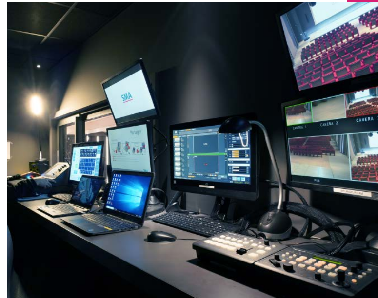
SMA BTP : salles de réunion, bulles de visioconférence, espaces de convivialité, espaces d'accueil, hall secondaire, bureaux de direction, affichage dynamique, au total plus de 100 espaces équipés en solutions technologiques. VIDELIO assure également la maintenance et l'exploitation du site.
